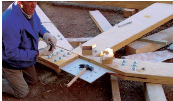
Figura 1.6: Se intercalan placas de acero para mejorar el rendimiento de la unión.
